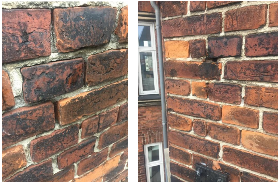
Murværk over altandøre på 2. sal er meget medtaget og svækket.
