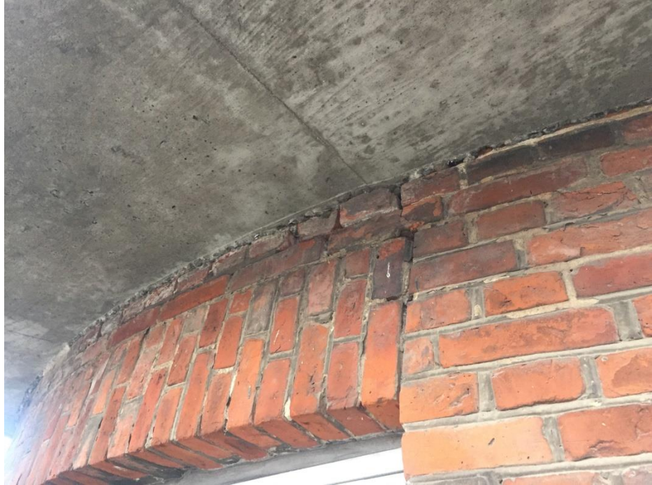
Murværk over altandøre på 2. sal er meget medtaget og svækket.
